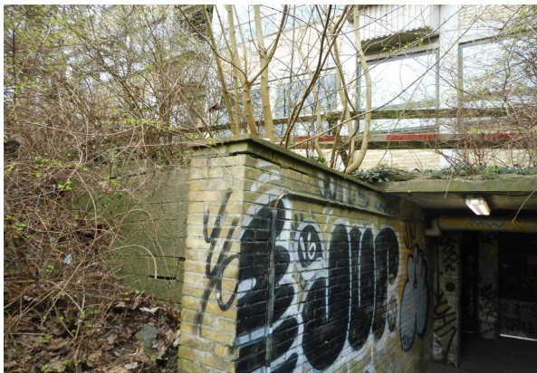
Foto 3: Murkrone er nedbrudt
