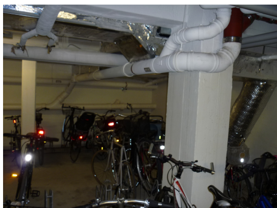
Foto 2: Faldstammen i kælder
