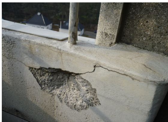
Foto 2: Betonafskalning på brystning
