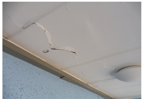
Foto 6: Muligvis fugtproblemer i betondæk ved elev. opg. 12
