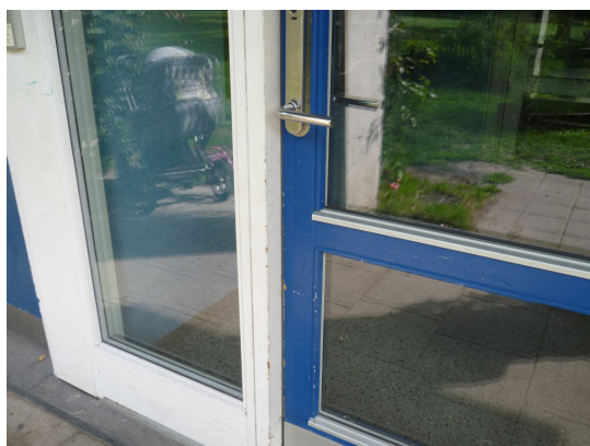
Foto 2: Opgangsdøre skal eftergås én gang årligt
