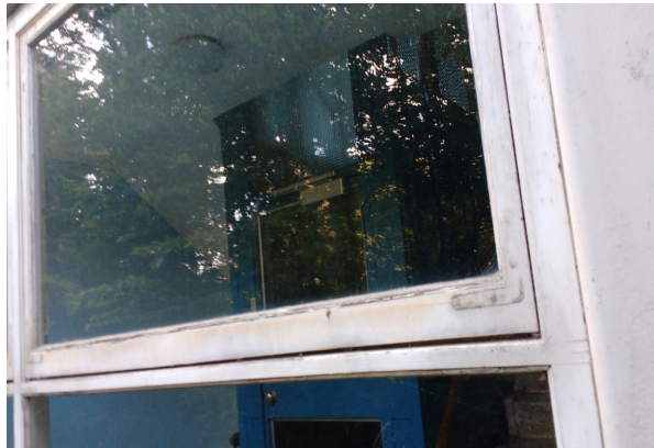
Foto 5: Afskalninger og åben malingsoverflade, udvendigt
