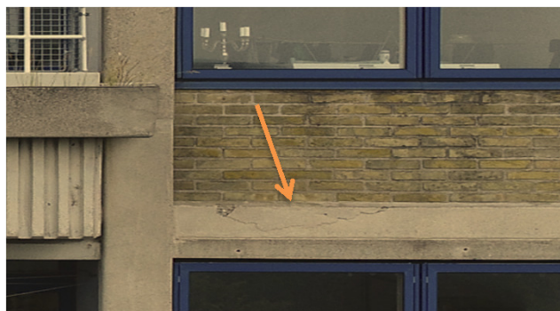
Foto 2: Afskalning i facaden (sydfacade)
