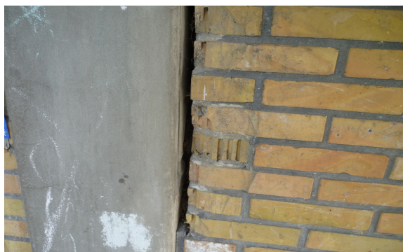
Foto 1: Afskalninger i facade i stueetage (sydfacade)
