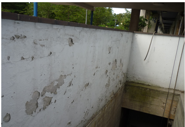
Foto 5: Kælderskakte malerafskalning
