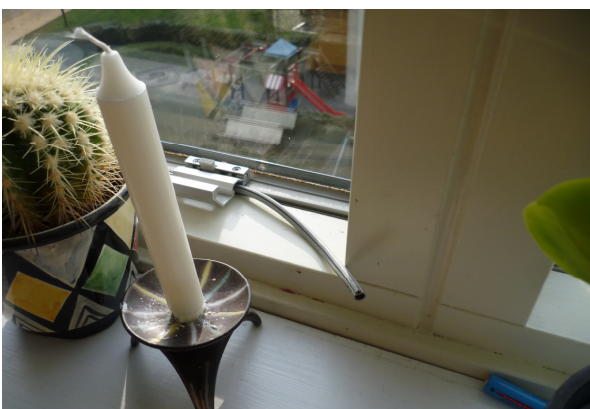
Foto 3: Tætningslister er løse
