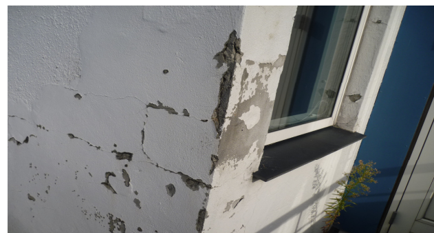
Foto 4: 11. sals letbetonfacader er medtaget
