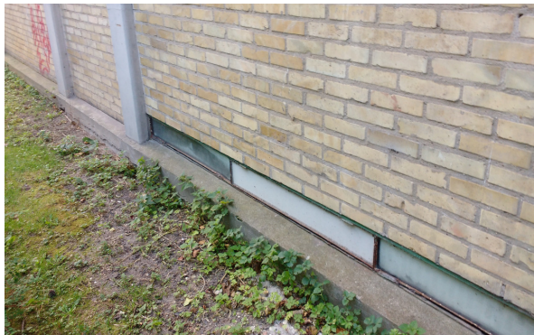
Foto 7: Kældervindue i nordfacaden, her blændet med krydsfiner
