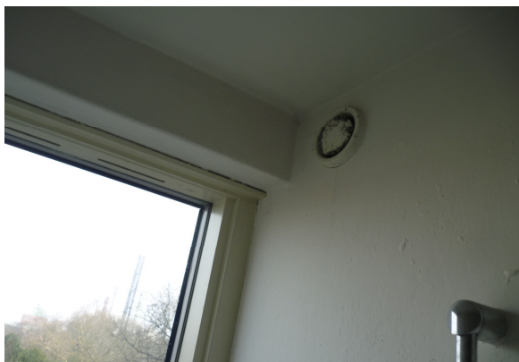
Foto 1: Udsugning på badeværelse er fyldt med støv
