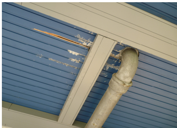
Foto 2: Mulig utæthed på ovenliggende afløb i altan
