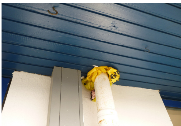
Foto 1: Mulig utæthed på afløb fra altan
