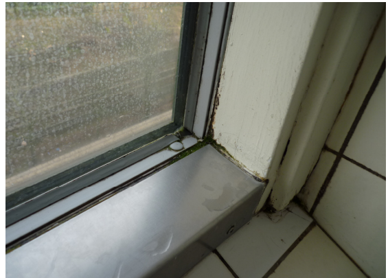
Foto 6: Bundstykke er under nedbrydning grundet badning
