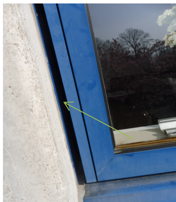
Foto 4: fugebånd omkring vinduerne på sydfacaden
