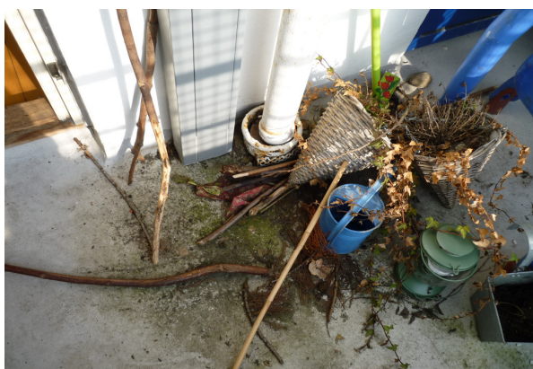
Foto 3: Afløb er spærret / tildækket af oplag på altan
