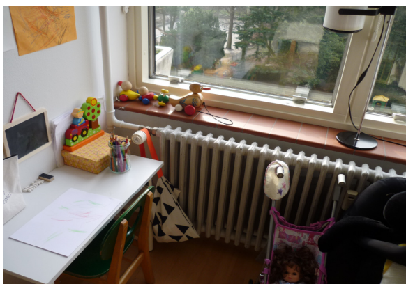
Foto 1: Ældre støbejerns radiator med termostathoved
