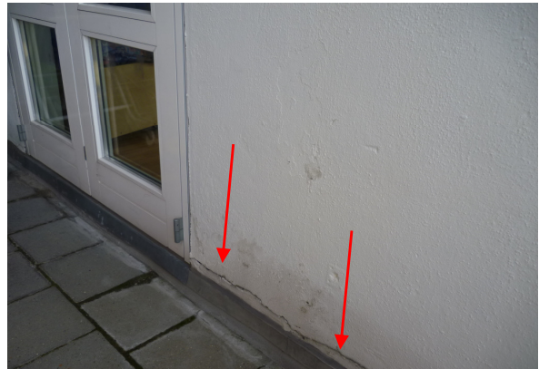
Foto 2: Fuge over inddækning er åben
