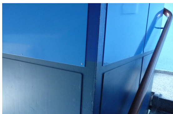
Foto 2: Brandisolering af trappetårn i opg. 20 (er udført)
