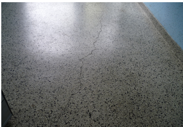
Foto 1: Revne i terrazzobelægningen
