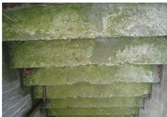
Foto 2: Udvendig kældertrappe med dårlige trin
