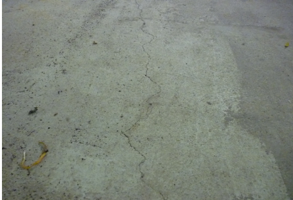
Foto 1: Revne i kældergulv
