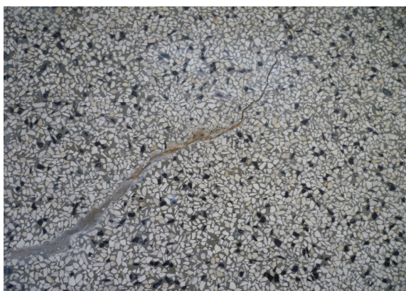
Foto 1: Revne i terrazzobelægningen , badeværelse
