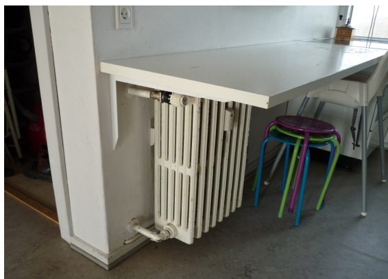
Foto 2: Ældre støbejerns radiator med termostathoved
