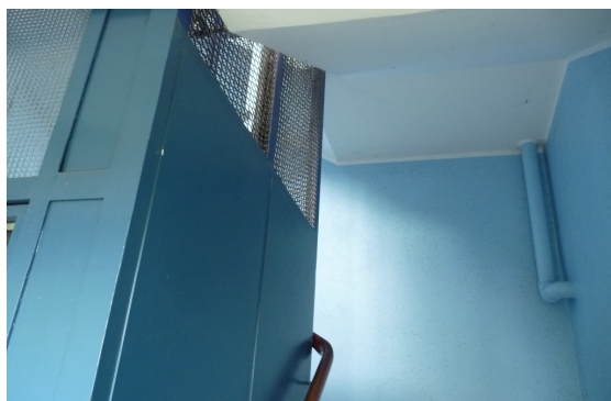
Foto 1: Elevatortårn der ikke er brandisoleret.
