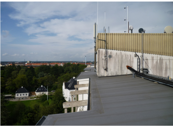
Foto 5: Tagbelægning på 11. sal
