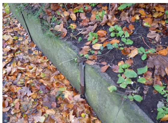
Foto 2: T-profiler er meget medtaget af rust
