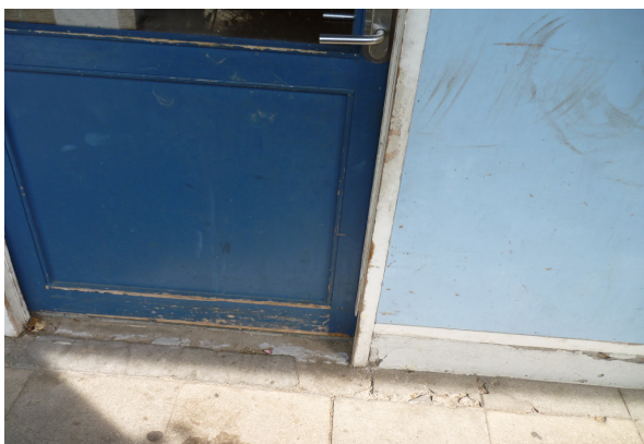
Foto 1: Døre og vinduer i stueetagen bør malerbehandles
